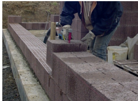
Dünnbettvermörtelung / LIAPLAN®-Mörtelschlitten
